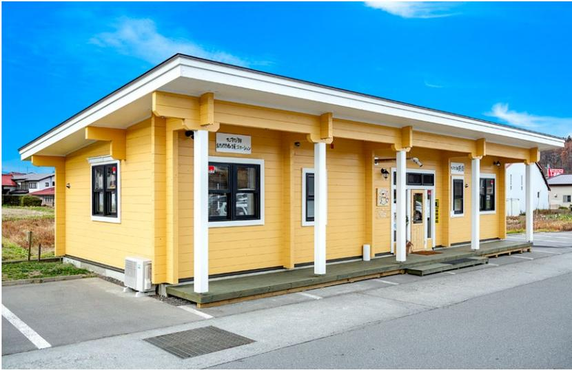
人の出入りがある店舗正面に雪が落ちると危険なので、後方に雪を落とす片流れ屋根とした。雪の重さを考え、垂木は通常より太いものを使用
